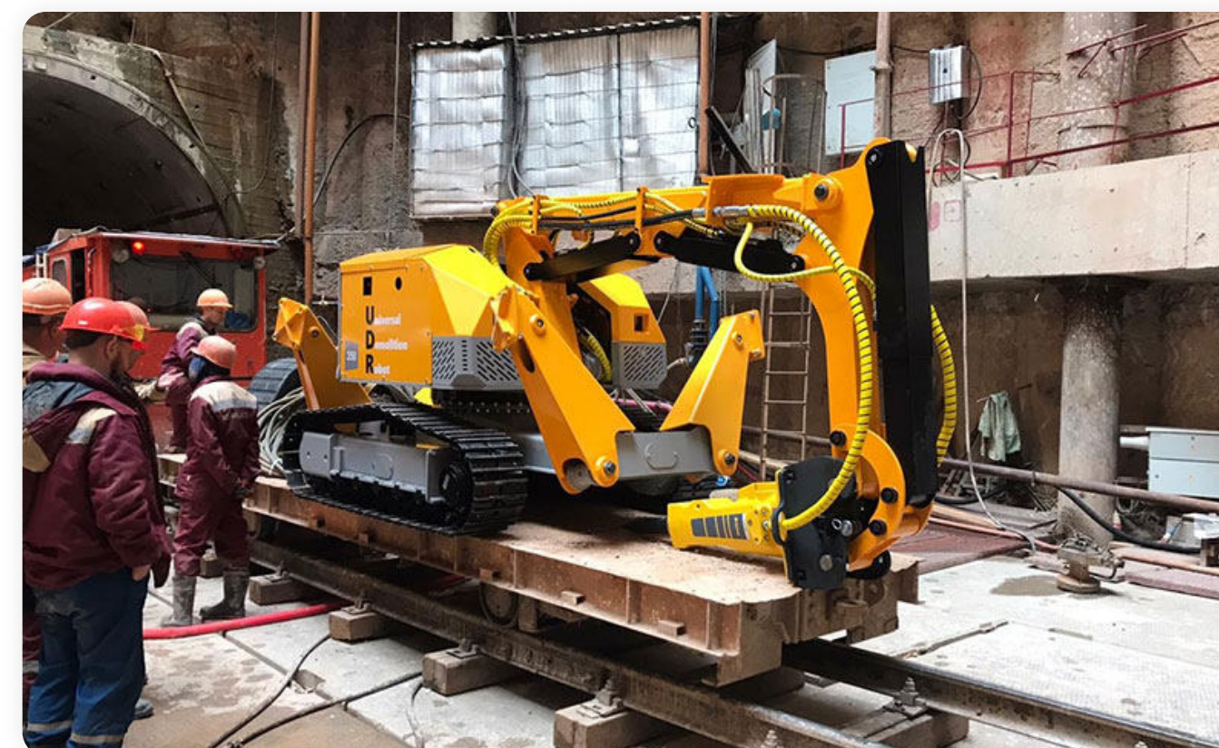
UDR350 на работе в тоннеле метро
