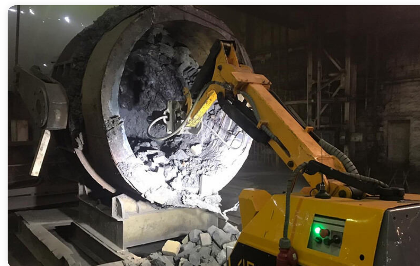
Чистка ковша на металлургическом заводе с помощью робота
